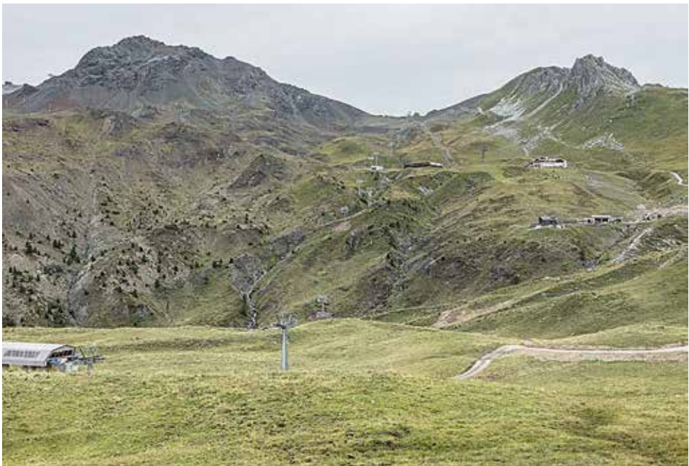
Abb. 5: Skigebiet Parsenn: Neue Skilift-Trasse im Bau (Ausschnitt), August 2017. Foto: Elias Siebert
