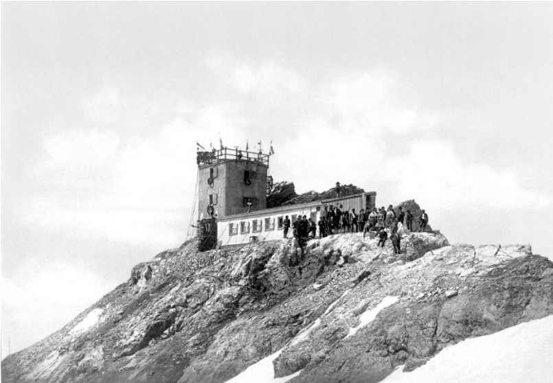
Einweihung des „Wetterturms“, 1900
