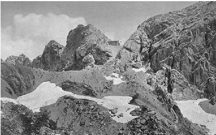
Das Gedenkkreuz unter der Hütte wurde erst 1922 angebracht (siehe Abschnitt 2.3.1)
