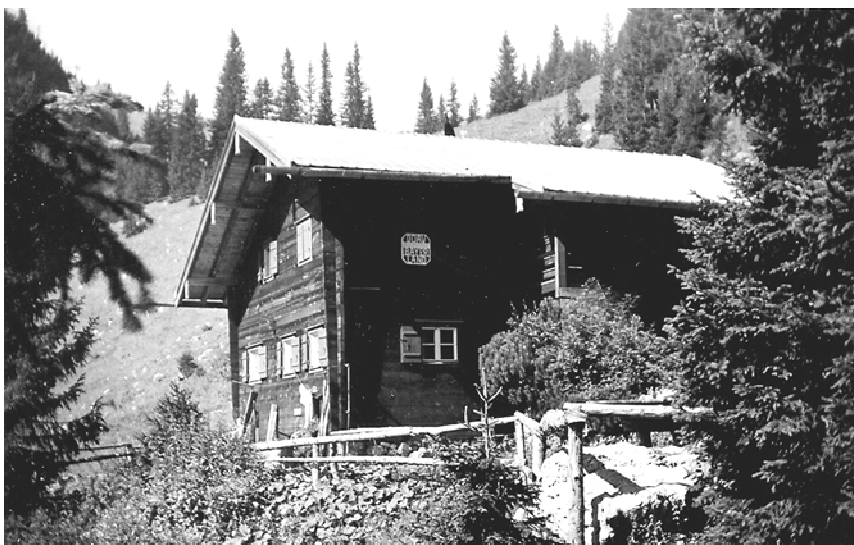
Die Raukopfhütte, fertiggestellt
