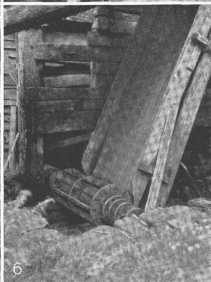
Abb. 1: Ländliche Gewerbemühle in Wems im Pitztal. Abb. 2: „Stockmühle“ bei St. Jakob in Deferegggen (Südtirol). Abb. 3: Höchstgelegene Mühlen Großdeutschlands bei den Rofner Höhen im Dytal (2010 m). Abb. 4: Messerrad einer Flachsbrechelmühle bei Längensfeld im Dytal. Abb. 5: Schöpfrad bei Brigen (Südtirol). Abb. 6: Schnellaufendes Wasserrad an einer Sägemühle (Vilsgratental, Südtirol)
