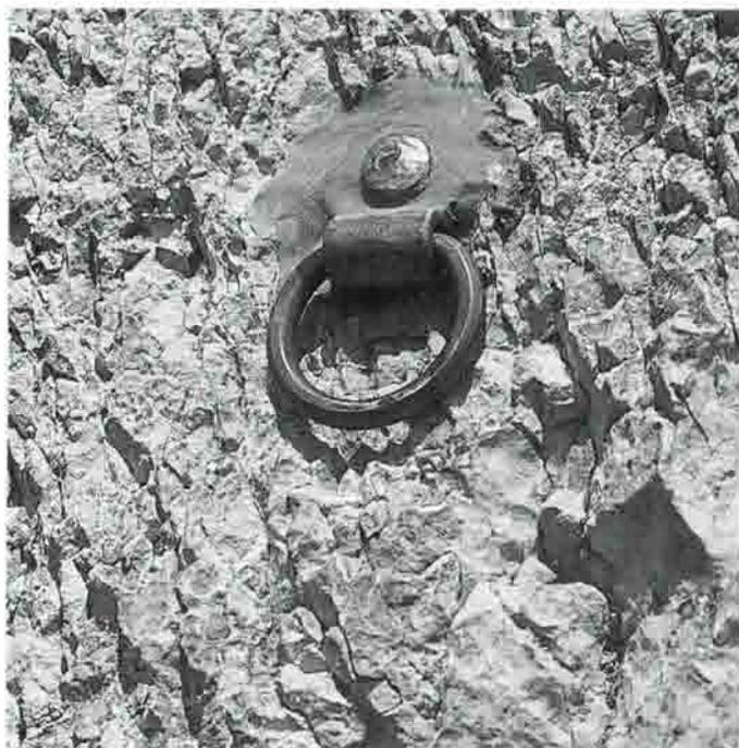
*Bild 3: DAV-Sicherheitshaken der 1. Generation; äußerliche Abdichtung mit Kunststoff.*
