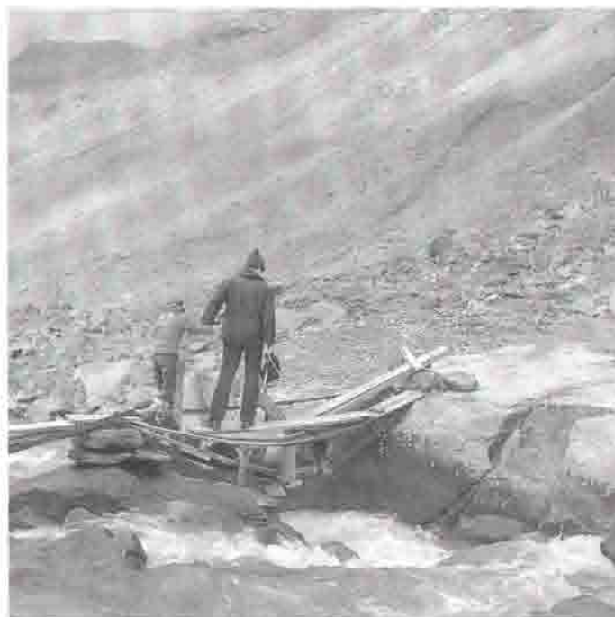
Brückerl über den Sexegerten-Bach
