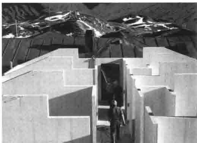
ERSATZBAU AN DER MEMMINGER HÜTTE MIT NEUER HOLZBAUTECHNIK
