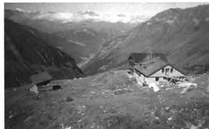
GENERALSANIERUNG DER GERAER HÜTTE IN DEN ZILLERTALER ALPEN
