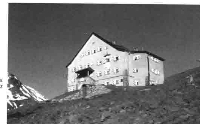
ABWASSERREINIGUNGSANLAGE AM HOCHJOCHHOSPITZ
