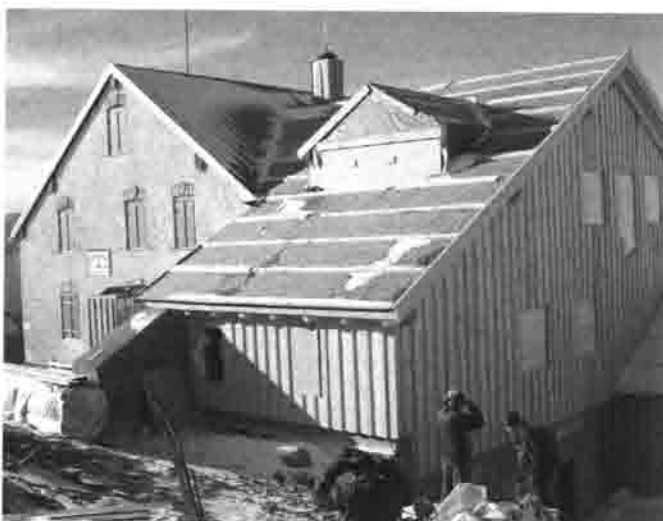
DIE GENERALSANIERUNG DER LEUTKIRCHER HÜTTE WURDE 2004 ABGESCHLOSSEN.
