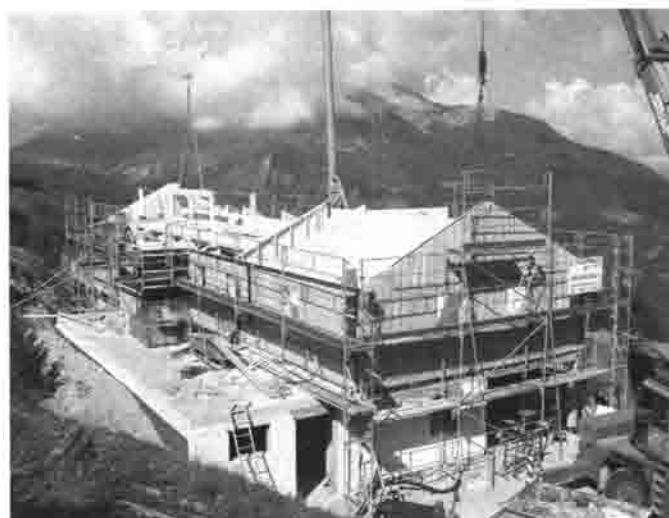
DIE GENERALSANIERUNG DER WOLFRATSHAUSER HÜTTE WURDE 2004 ABGESCHLOSSEN.
