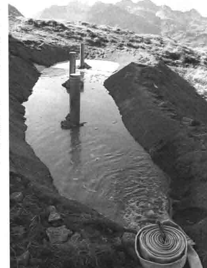
AUF DER STUTTARTER HÜTTE WURDE IM HERBST 2004 EINE VERERDUNGSANLAGE ERRICHTET.
