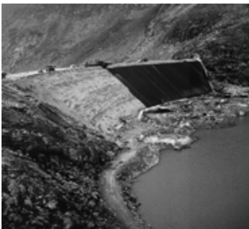
DER BAU VON SPEICHERSEEN UND KRAFTWERKS-INFRASTRUKTUR BELASTET MENSCH UND NATUR ÜBER MEHRERE JAHRE
