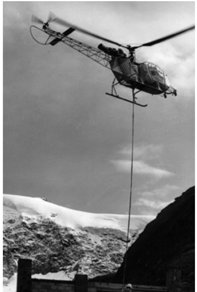
AM TASCHACHHAUS MUSSTEN 2005 UMFANGREICHE RENOVIERUNGSARBEITEN DURCHFÜHRT WERDEN
