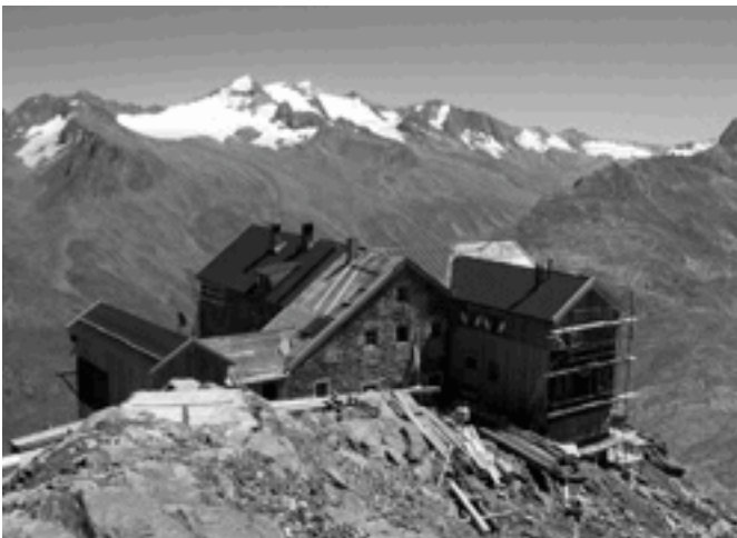
DIE HÖCHSTGELEGENE BAUSTELLE BEFAND SICH 2005 AM RAMOLHAUS.
