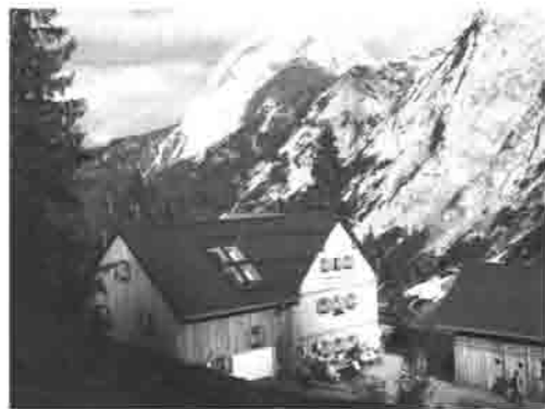
DIE OTTO-MAYR-HÜTTE DER SEKTION AUGSBURG WURDE GRUNDLEGENDE SANIERT.
