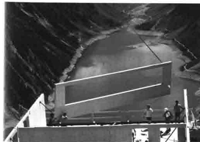
Bauarbeiten in luftiger Höhe auf der Olpererhütte
