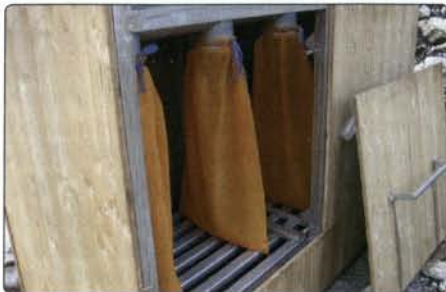
Filtersackanlage für die Entfernung des Feinschlammes aus dem Nachklärbecken.
