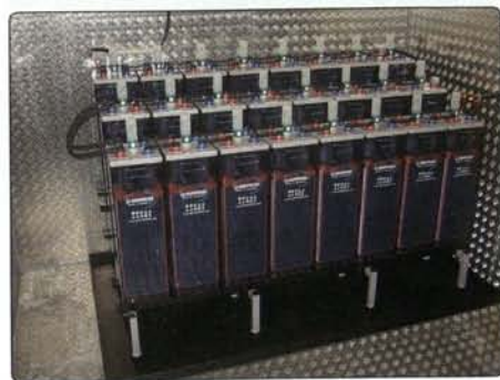
Für sonnenlose Tage wird ein Batteriesatz geladen.
