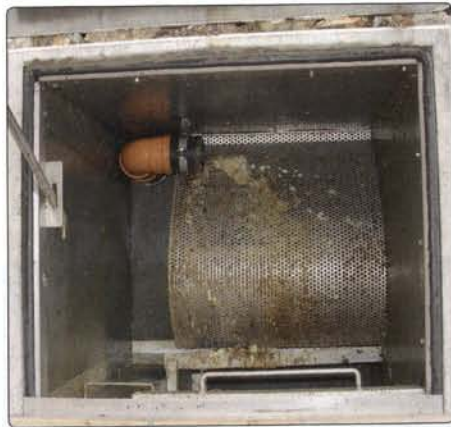
Bogensieb zur Feststoffabtrennung auf der Hochschöber Hütte
