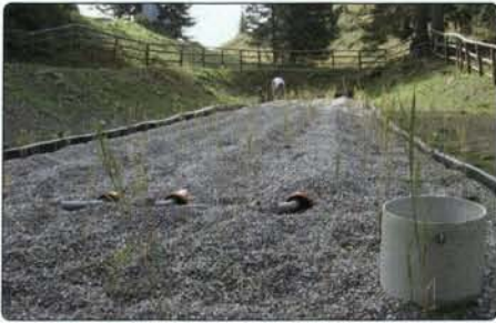
Pflanzenkläranlage kurz nach dem Bepflanzen mit Schilfpflanzen
