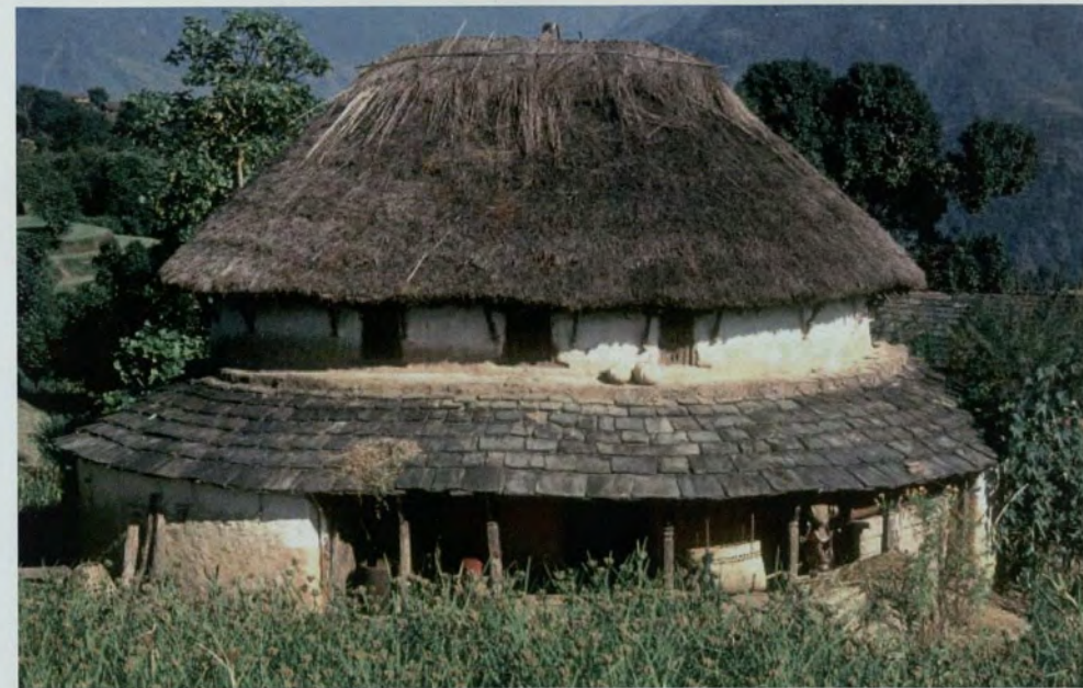
Bild 13 Ein Ovalhaus der Gurung (nepali- scher Volksstamm) auf der Südseite der Annapurna. Ein Haus, gebaut aus den vorhandenen Materialien, die in der näheren Umgebung zu finden sind. Das Strohdach isoliert hervorragend gegen Hitze und Kälte. Den starken Niederschlägen in dieser Gegend entspricht die Dachneigung. Die mit Schiefer- platten überdachte Veranda dient als Aufenthaltsplatz und schützt zusätzlich die Außenmauer vor Nässe. Heute gibt es nur noch wenige dieser Häuser. Eines Tages werden wir es wiederfinden in einem nepalischen Freilichtmuse- um, vielleicht ähnlich Glentleiten in Oberbayern.
