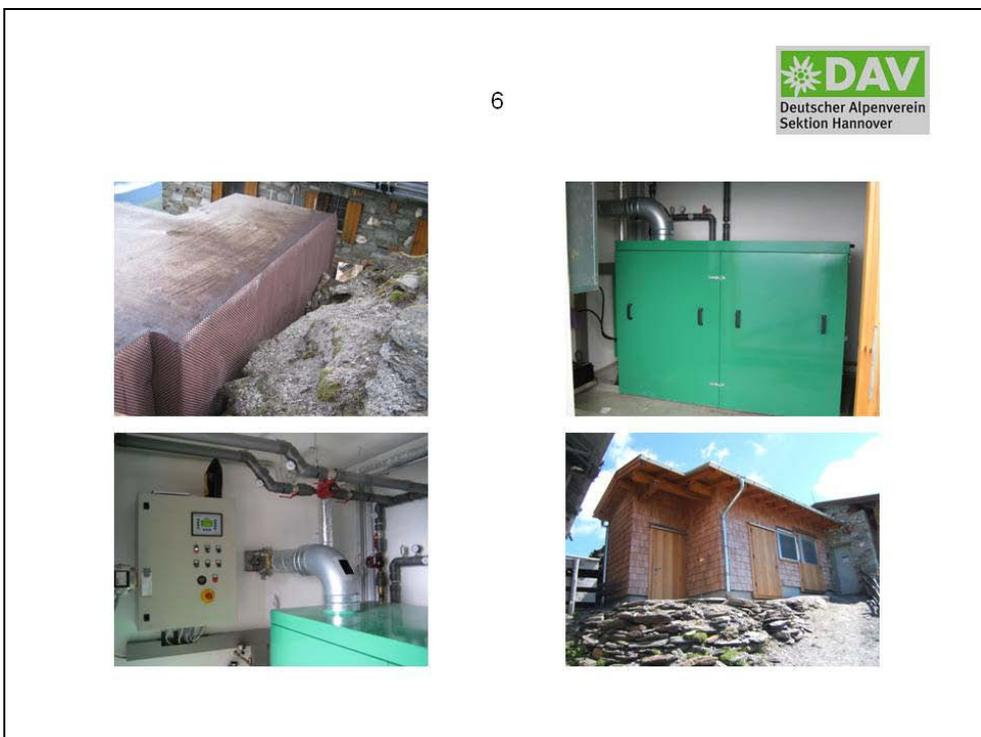
Von links oben nach rechts unten: Gebäudeabspernung mit Betondecke, BHKW mit Schalldämmung, Schaltkasten, fertiges BHKW-Gebäude, rechts Seilbahngebäude.
