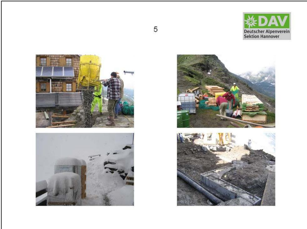
Von links oben nach rechts unten: Füllkiesverfüllung zum Felskamm, angeflogene Baustoffe, Wintereinbruch im August, Anschlussleitungen und Fundament.
