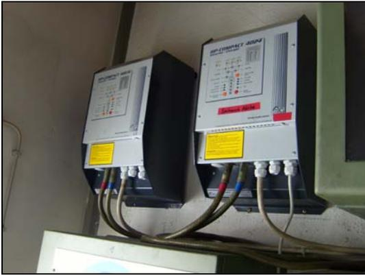
Abb. 10: Wechselrichter
