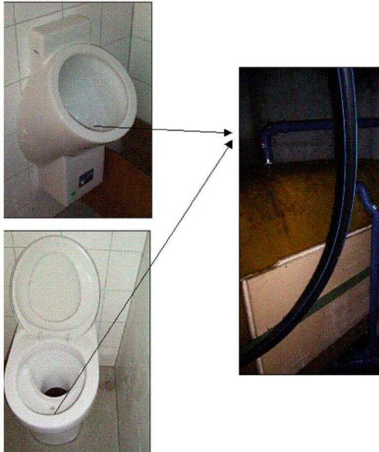
Die Flüssigkeit aus der Separationstoilette sowie den wasserlosen Urinalen fließt in den Speichertank. Die gespeicherte Flüssigkeit wird in kleine Gebinde gepumpt und abtransportiert und kann auf der nahe gelegenen Alpe entsorgt werden (auf dem Bild ist der endgültige Einbau und Anschluss des Speichertanks noch nicht erfolgt)
