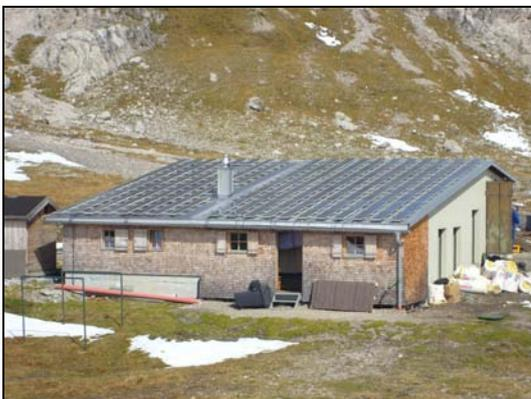
Abb. 3: Photovoltaikanlage
