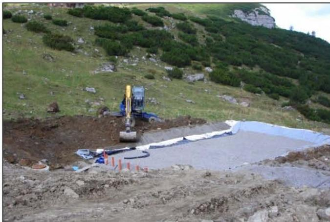
Bodenfilter nach Einbau der Kiesschicht. Die Drainageröhre wurde bereits verlegt, zu sehen sind hier die biologisch wirksame Schicht, der Folie zur Abdichtung des Kiesbettes.
