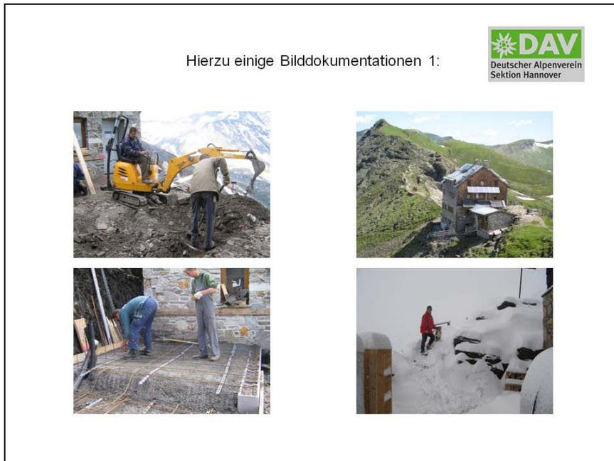
Von links oben nach rechts unten: Felskammernfernung und Baugrunderstellung mit Kleinbagger, Hütte mit Seilbahngebäude, Betonfundamente, Wintereinbruch.
