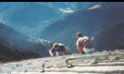
Montage der Solartechnik an der Tölzer Hütte
