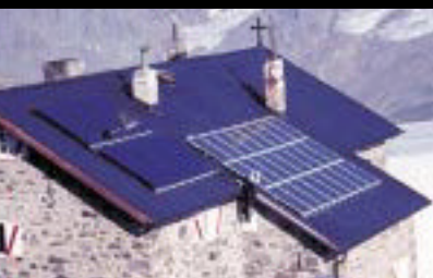
Technische Ausrüstung des Brandenburger Hauses: links die Sonnenkollektoren und rechts die Photovoltaikanlage
