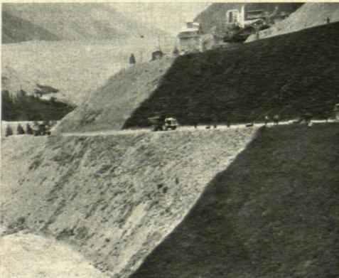
Abb. 4: Großflächige Rekultivierungsarbeiten mittels Strohecksaat beim Kaunertalkraftwerk. 1700 m Seehöhe.
