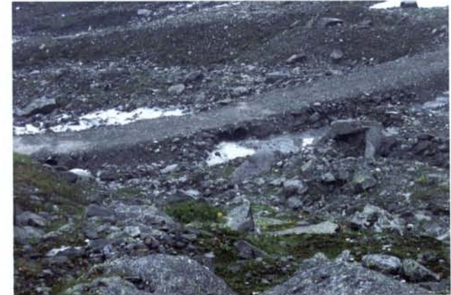
Der Hüttenweg nach der Reparatur
