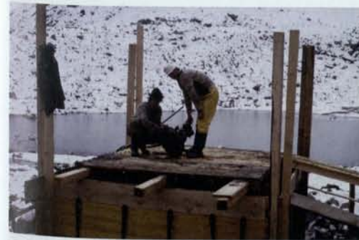
Schalarbeiten am Turbinenhaus
