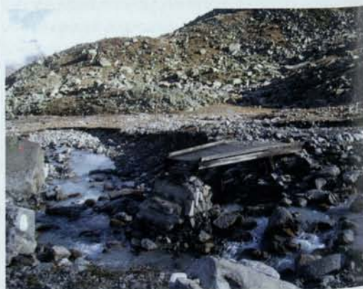
Beim Unwetter in der Silvretta am 22.08.2005 werden alle Bachübergänge zum Madlenerhaus von den Wassermassen weggerissen.
