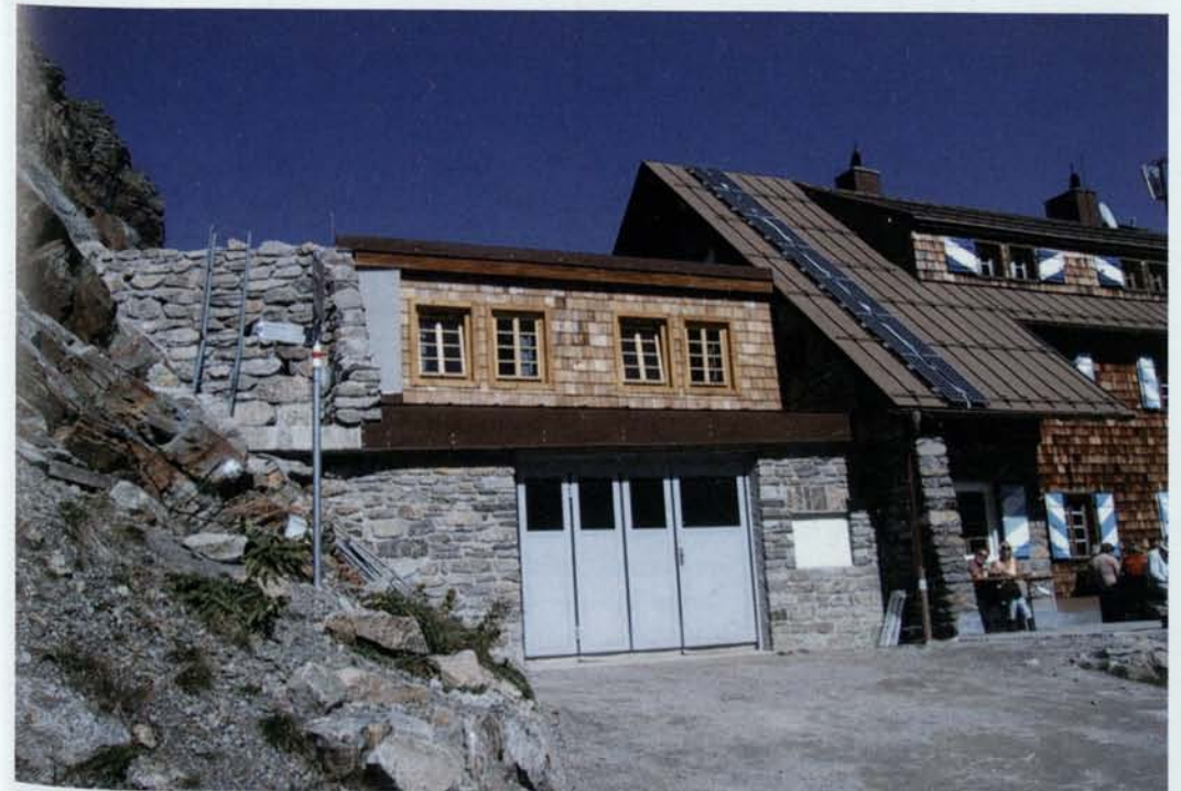
Der Anbau ist vollendet und fügt sich harmonisch in das Gesamtbild der Hütte. Die Fotomontage zur Planeinreichung ist fast nicht vom Original zu unterscheiden.
