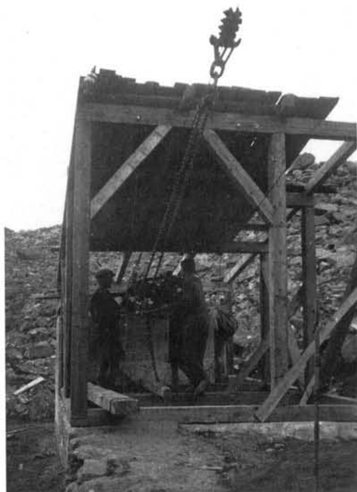
Talstation der Transportbahn für das Hüttenbaumaterial
