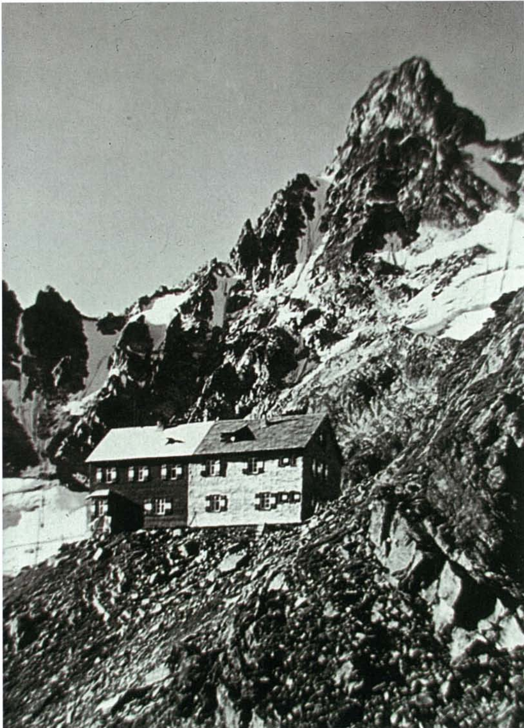
Hütte mit Erweiterungsbau 1926
