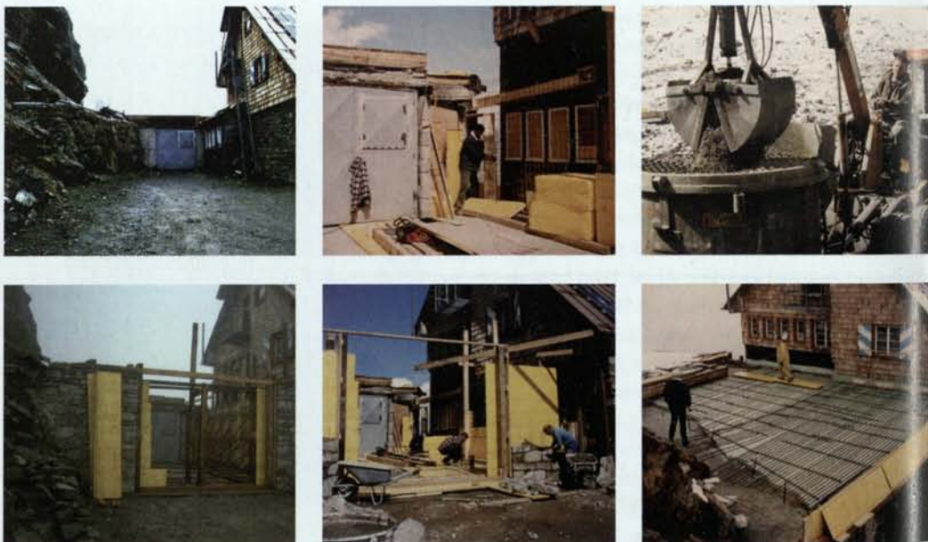
Erweiterung der Garage nach dem Bergsturz
