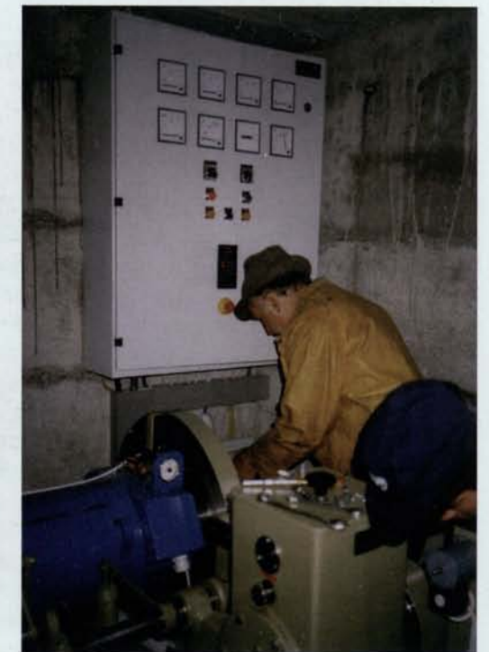
Montage der Turbine
