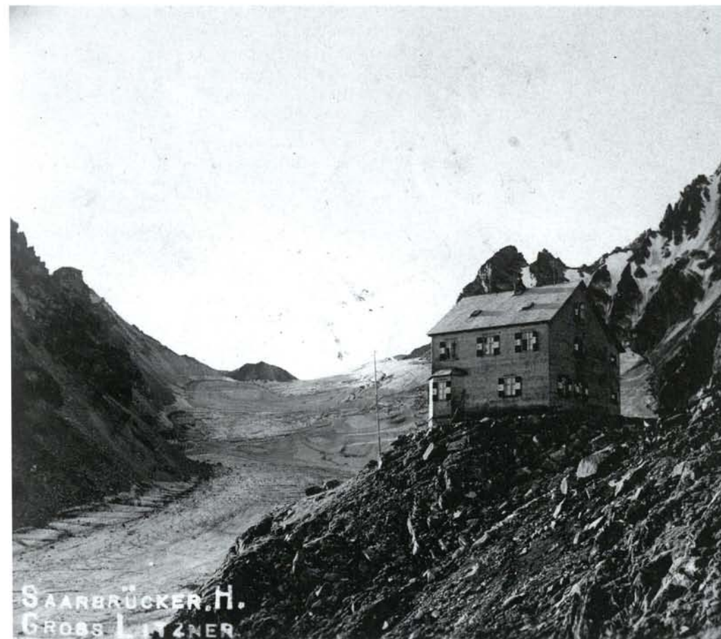
Die Saarbrücker Hütte wurde ca. 50 m oberhalb des damaligen Eisrandes des Litznergletschers erbaut. Das Gletschertor diente lange Zeit als natürlicher Kühlschrank für die Vorratshaltung.
