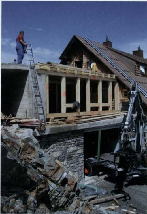
Das Fachwerk steht
