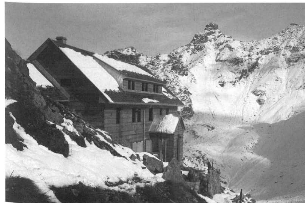
Der Rohbau steht
