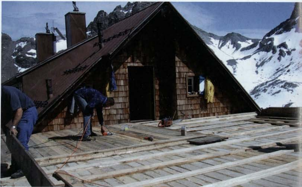
Rohbau der Pächterwohnung. Die Bodenkonstruktion auf dem Dach der Garage wird erstellt.
