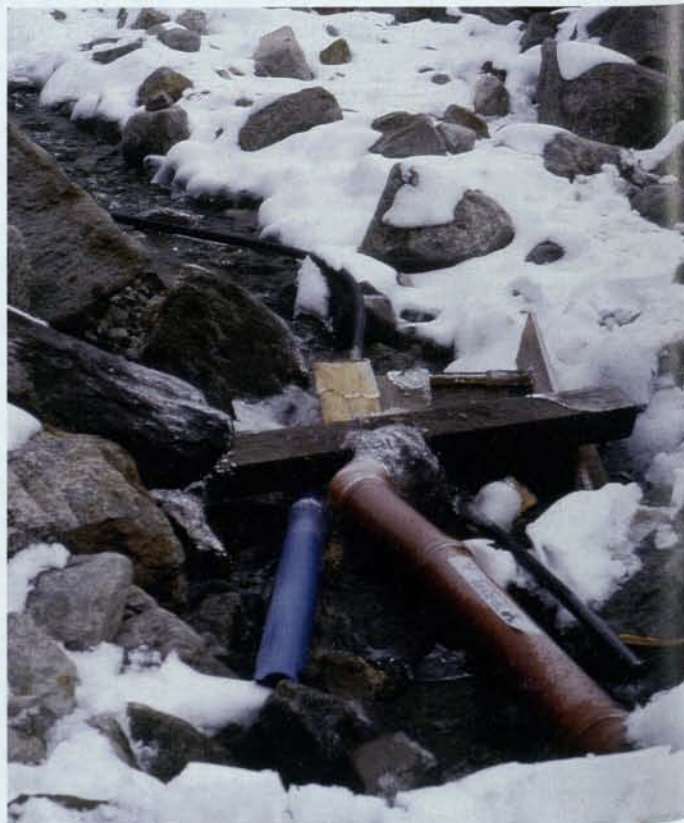
Die alte Wasserfassung
