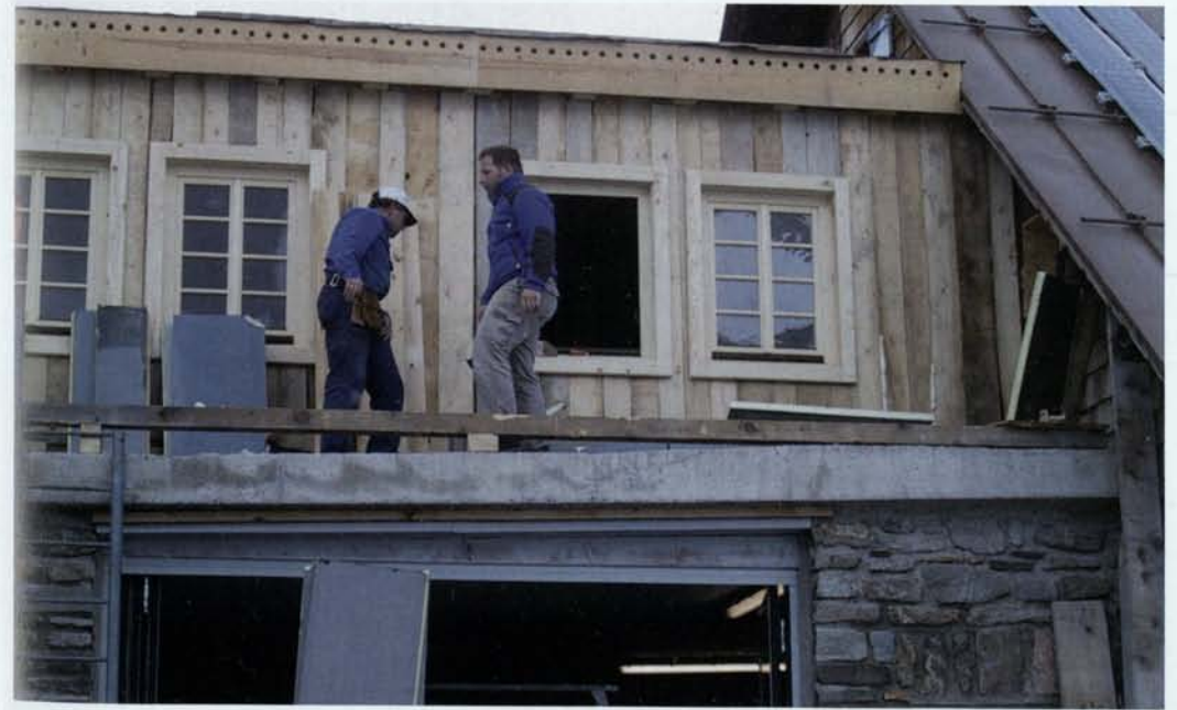
Letzte Arbeiten an der Fassade – Schindeln und Fensterläden fehlen noch.
