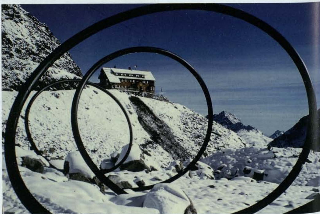
Das Druckrohr für das Kleinwasserkraftwerk wartet auf ihre Verlegung.
