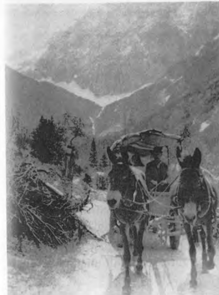
Von 1908 bis 1946 erfolgte die ganze Versorgung des Hauses durch ein Zwei-spänner-Multifuhrwerk.
