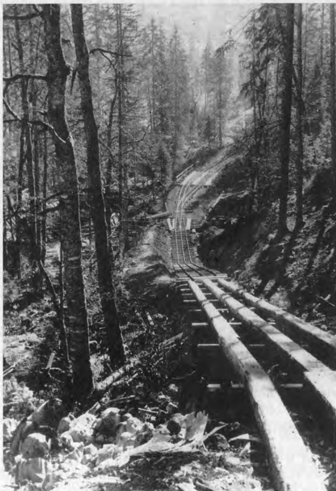
Beispiel eines Bremsbergs der Waldbahnstrecke.
