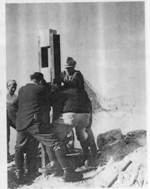
Verankern des Fundaments für das neue Gipfelkreuz auf dem 2153 m hohen Hochalmkreuz im Sommer 1966 (eingeweiht im Juli 1967).
