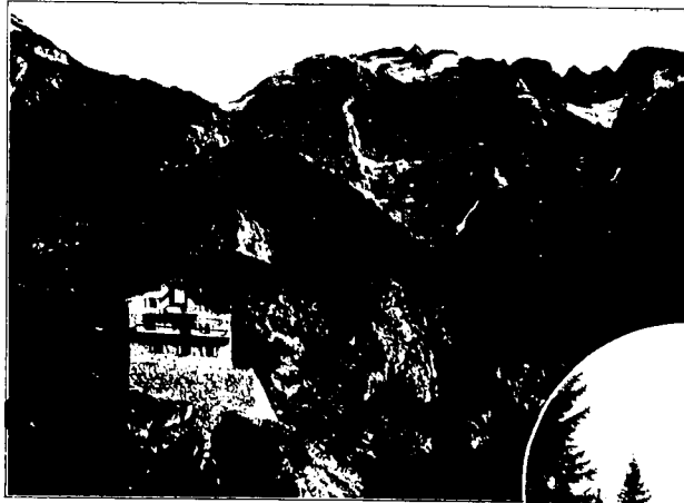
Das neue Haus auf der Hochalm mit Westausblick von Norden
