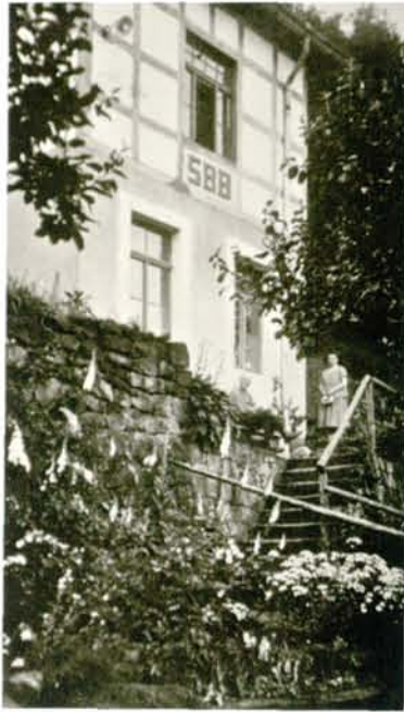
Links: Die Bundeshütte in Wehlen Rechts: Arbeitseinsatz an der Bundeshütte
