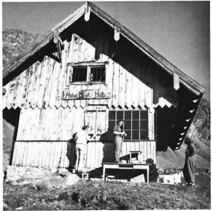
Die Verandafenster werden eingesetzt
