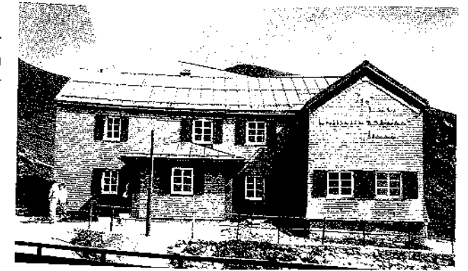
Das Haus heute - Westansicht
