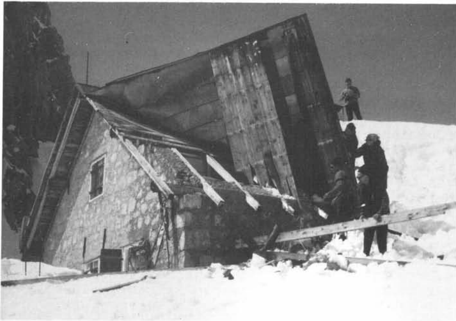
Beträchtlicher Schaden entstand am Prinz-Luitpold-Haus durch Lawinenabgang im Winter 1966/67.
