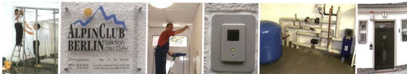
Neues in der Geschäftsstelle (vlnr): Einbau einer Zwischenwand, neues Schild, Renovierung nach Trockenlegung der Grundmauern, Alarmanlage ausgetauscht, neues Heizungszentrum für die Fernwärme und eine neue Haustür aus Aluminium
