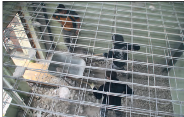
Umbaumaßnahmen Kletterhalle im Vereinsheim Foto: W. Reichert
