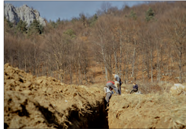
Bau der Wasserleitung für das Kletterheim
