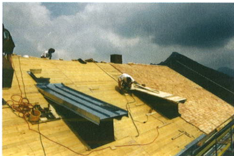
Ein neues Dach für die Hütte
