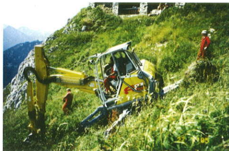
Schreibagger beim Kanalbau
