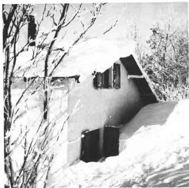
Die „Wagenthalhütte“ im Winter (vor dem Umbau)
