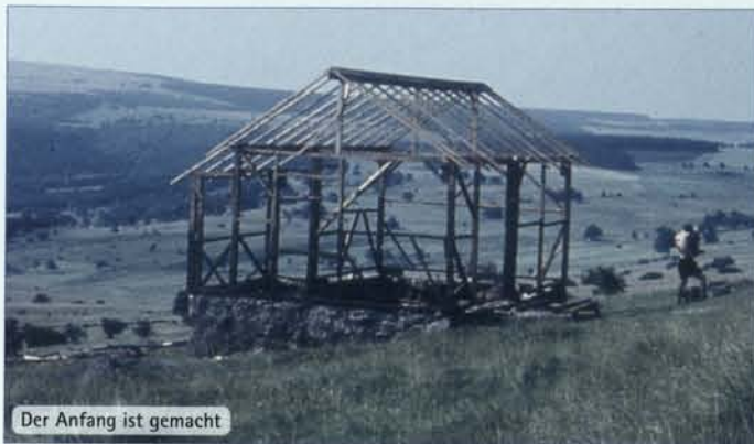
Steinesuchen für das Fundament
