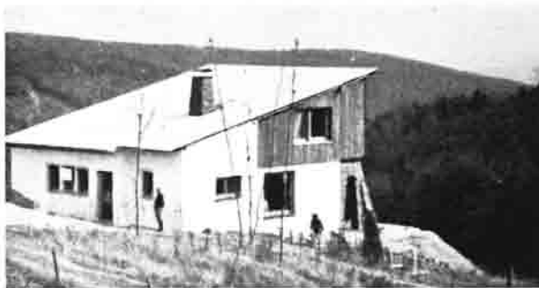
Endlich unter Dach und Fach
