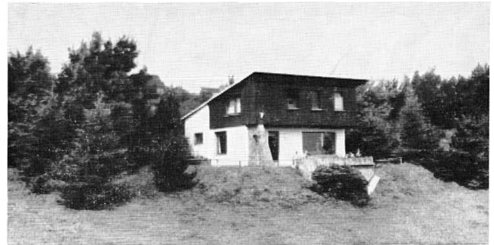
Die Rheydter Hütte im Sommer 1972, ein Kleinod unter den Mittelgebirgshütten im DAV.
