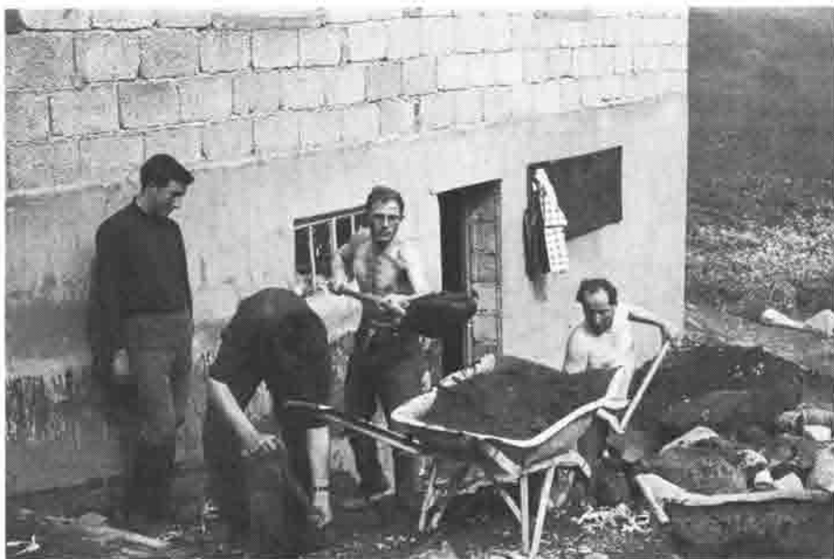
Hier geht es an die Außentreppe.
