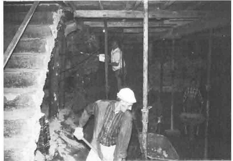
So fängt ein Neubau (fast) immer an: Ausschachten.
