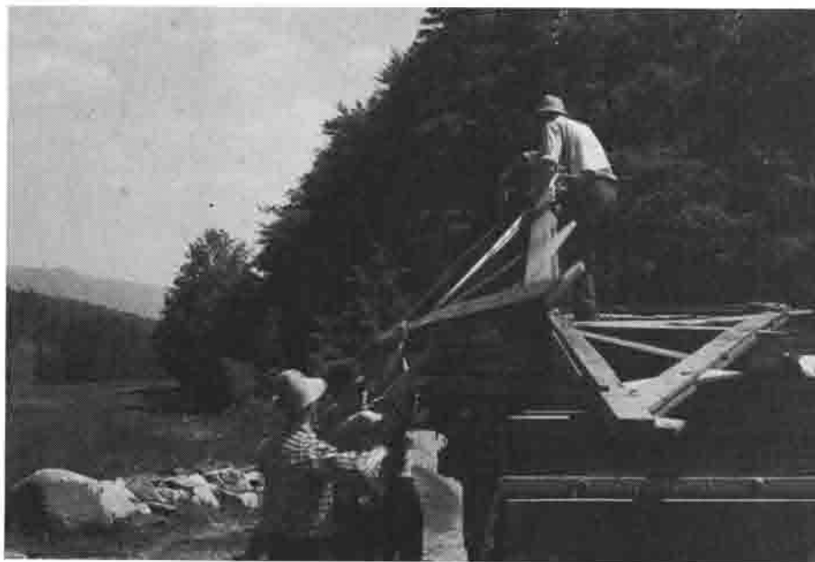
Die Hütte wird abgeladen.
