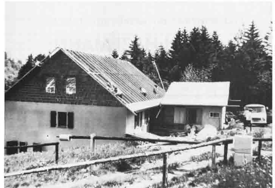
Jetzt wird's richtig: Das neue Dach, um 90° gedreht.
