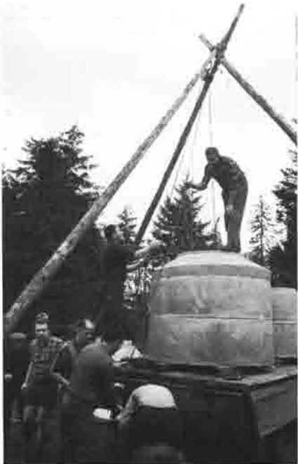
Die Klärgrube wird abgeladen.
