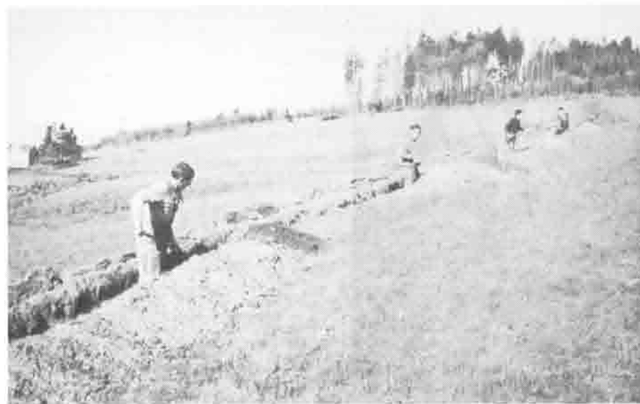
. . . 370 m Erdkabel verlegt.
