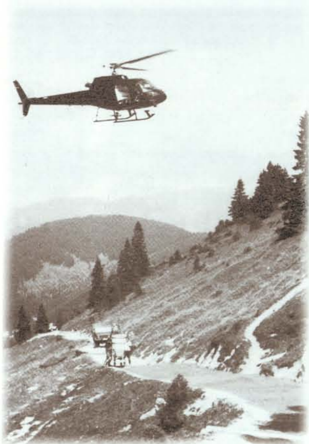
Fünfhundert Betonbomben flog der Hubschrauber vom Langenthal nach oben. Dort hatten die Helfer gerade drei Minuten Zeit, ehe eine neue Ladung heranknatterte.
