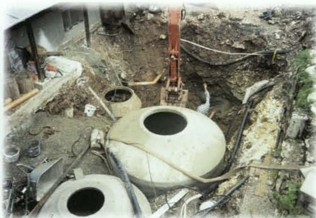
Zwei von den vier Behältern sind eingesetzt. Oberhalb sieht man die letzte Kammer der alten Anlage
