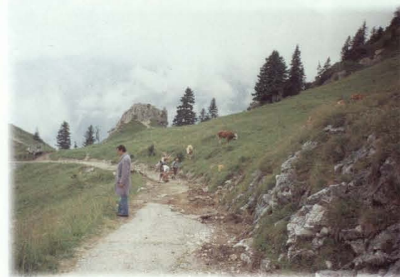
Teilstück des Pürschlingweges zum Betonieren bereit
