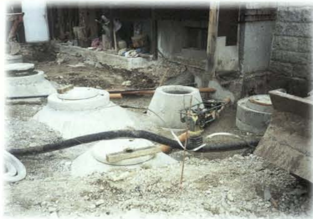
Die neue Kläranlage kurz vor der Fertigstellung
