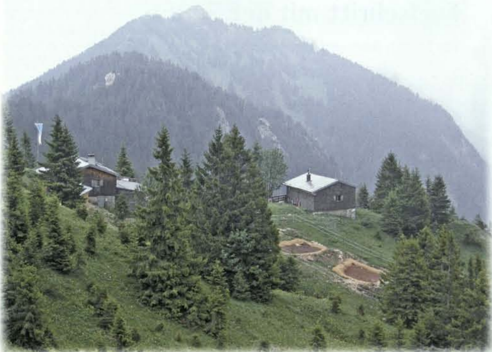
Die neue biologische Kläranlage besteht aus 2 Pflanzenbeeten und reinigt die Abwässer beider Hütten.
