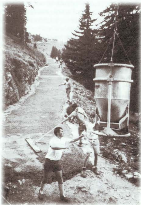
Mit beachtlichem fliegerischen Können setzte der Hubschrauberpilot die Betonbombe millimetergenau an der gewünschten Stelle ab.
