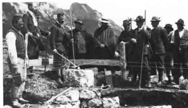
Grundsteinlegung am 14. August 1910
