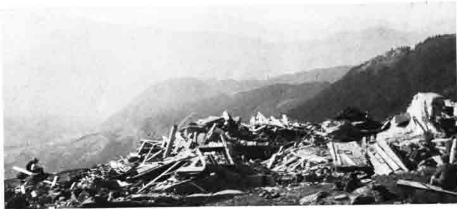
Die Trümmer unserer alten Hütte.
