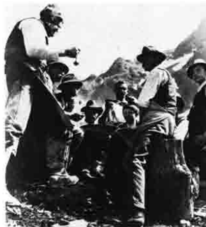
Die Arbeiter am Hüttenbau
