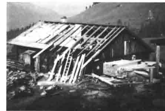
Die abgedeckte Simbacher Hütte.
