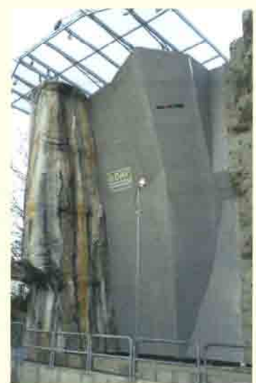
Fertigstellung der neuen Kletterwand
