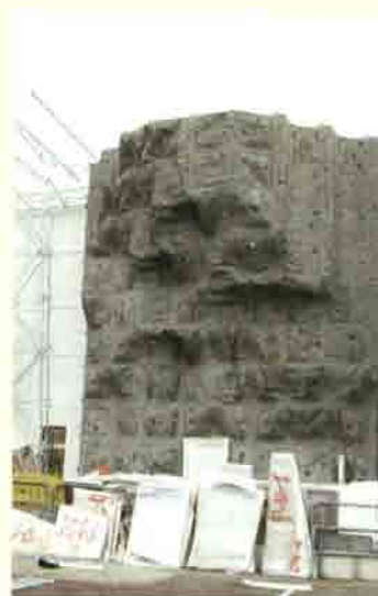
Aufbau der neuen Wand
