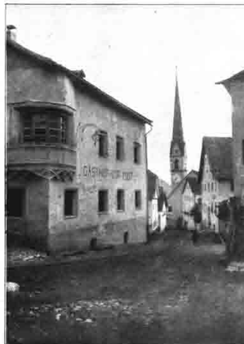
Straße in Wemms
