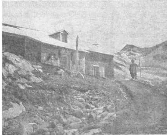
Braunschweiger Hütte (mit Anbau) 1895
