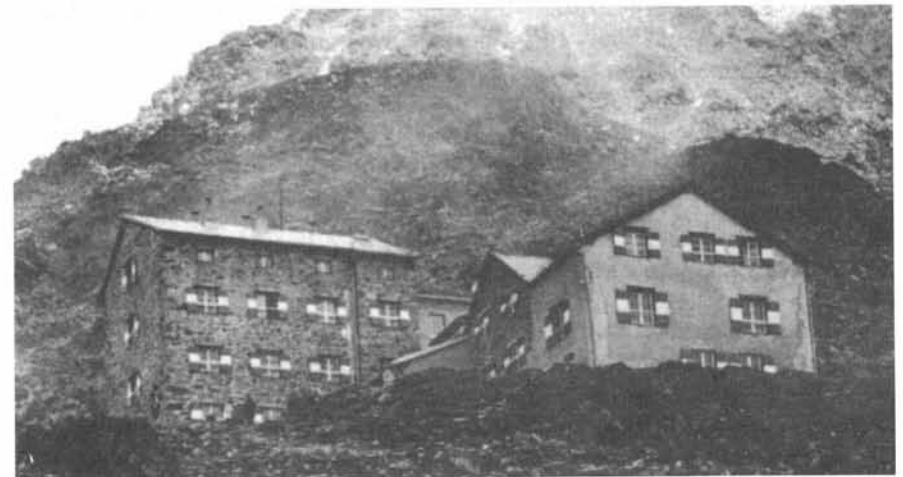
Hütte nach der Erweiterung 1978
