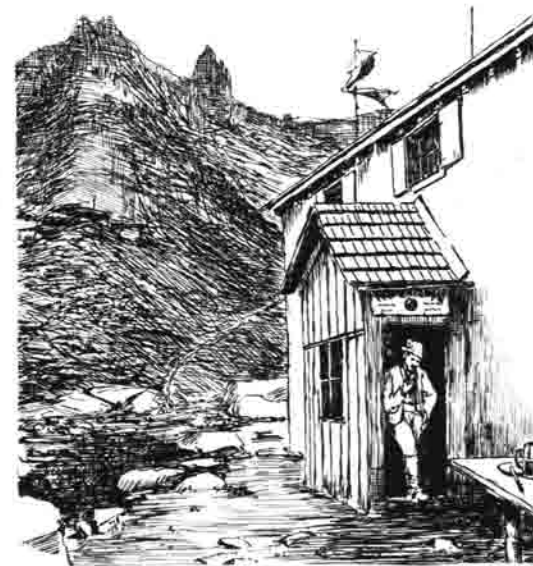
Eingang der Chemnitzerhütte.
