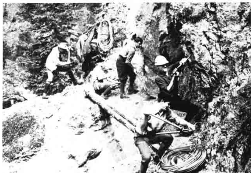
Arbeitseinsatz im Birkental beim Wegebau
