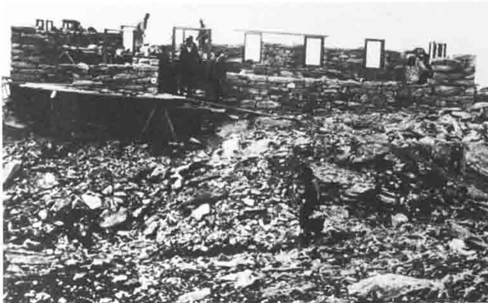
Bau der Duisburger Hütte 1909.
