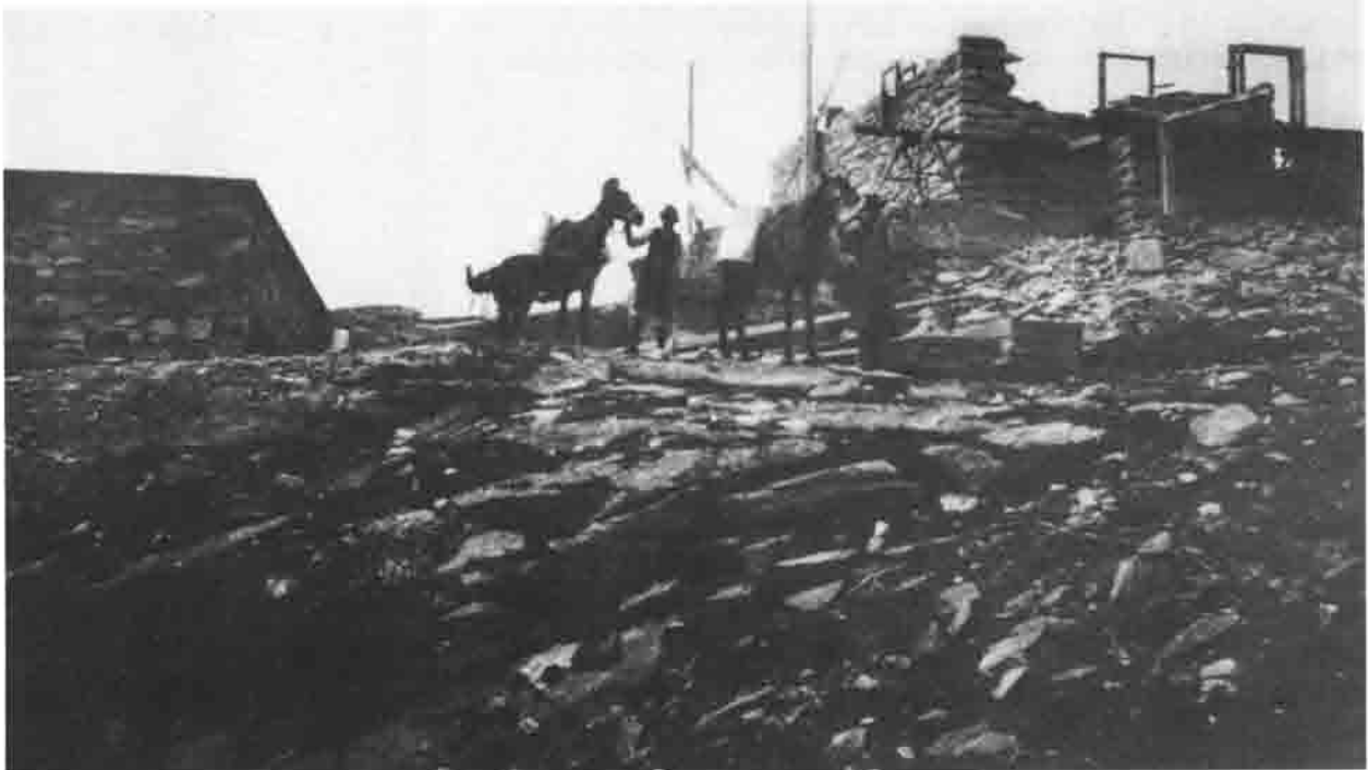
Transport von Baumaterial durch Mulis 1909.
