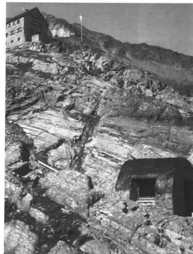
Hütte mit Kraftwerkhaus
