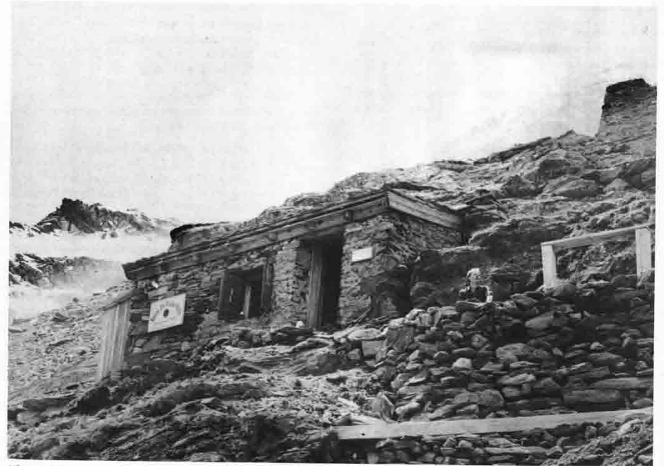
Kleine Philipp-Reuter-Hütte (2 690 m); rechts oben ein Mauerrest der Neuen Essener Hütte (Philipp-Reuter-Hütte).
