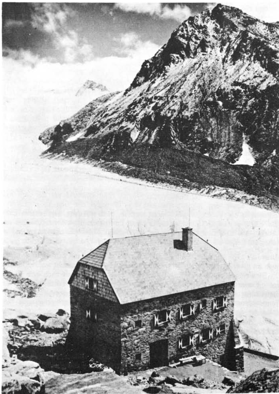
Neue Essener Hütte
