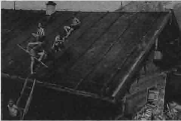
Im Jahre 1937 wurde das Dach geteert.
