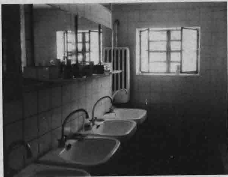
Der Herrenwaschraum im Hüttenanbau.
