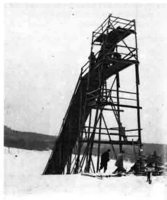
Der zweite, verbesserte Anlaufurm ist fertig
