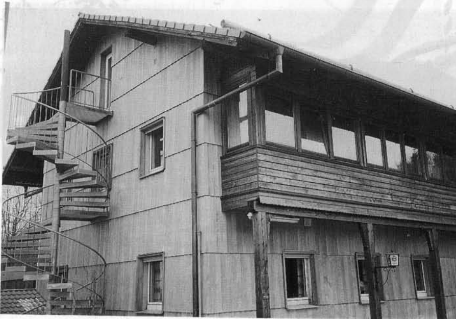
Das neue Bild der Enzianhütte mit frischem rotem Dach und der Verkleidung mit rhöntypischen Wettbrettern (Bild oben). – Ebenfalls neu: die Fluchttreppe an der Rückseite der Hütte (Bild unten).
