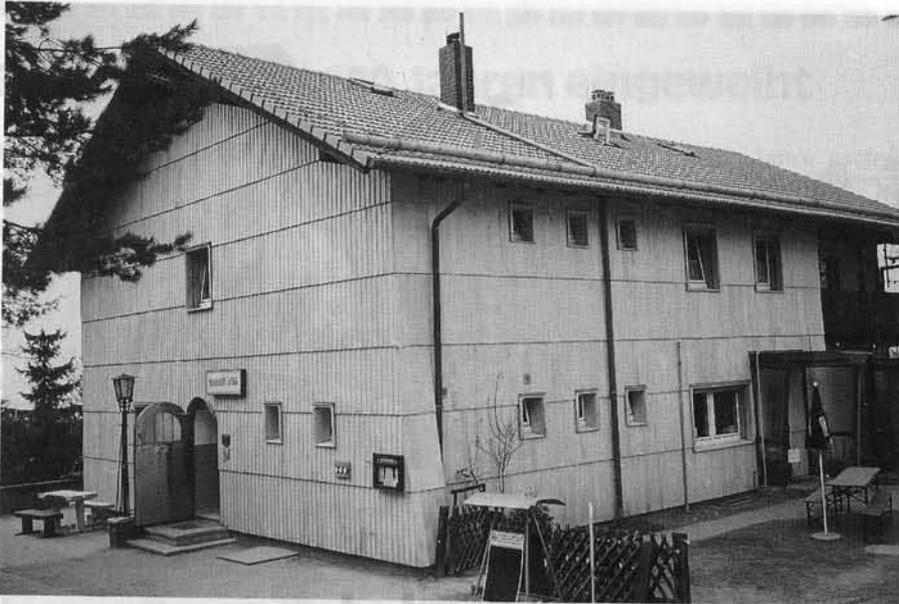
Das neue Bild der Enzianhütte mit frischem rotem Dach und der Verkleidung mit rhöntypischen Wettbrettern (Bild oben). – Ebenfalls neu: die Fluchttreppe an der Rückseite der Hütte (Bild unten).
