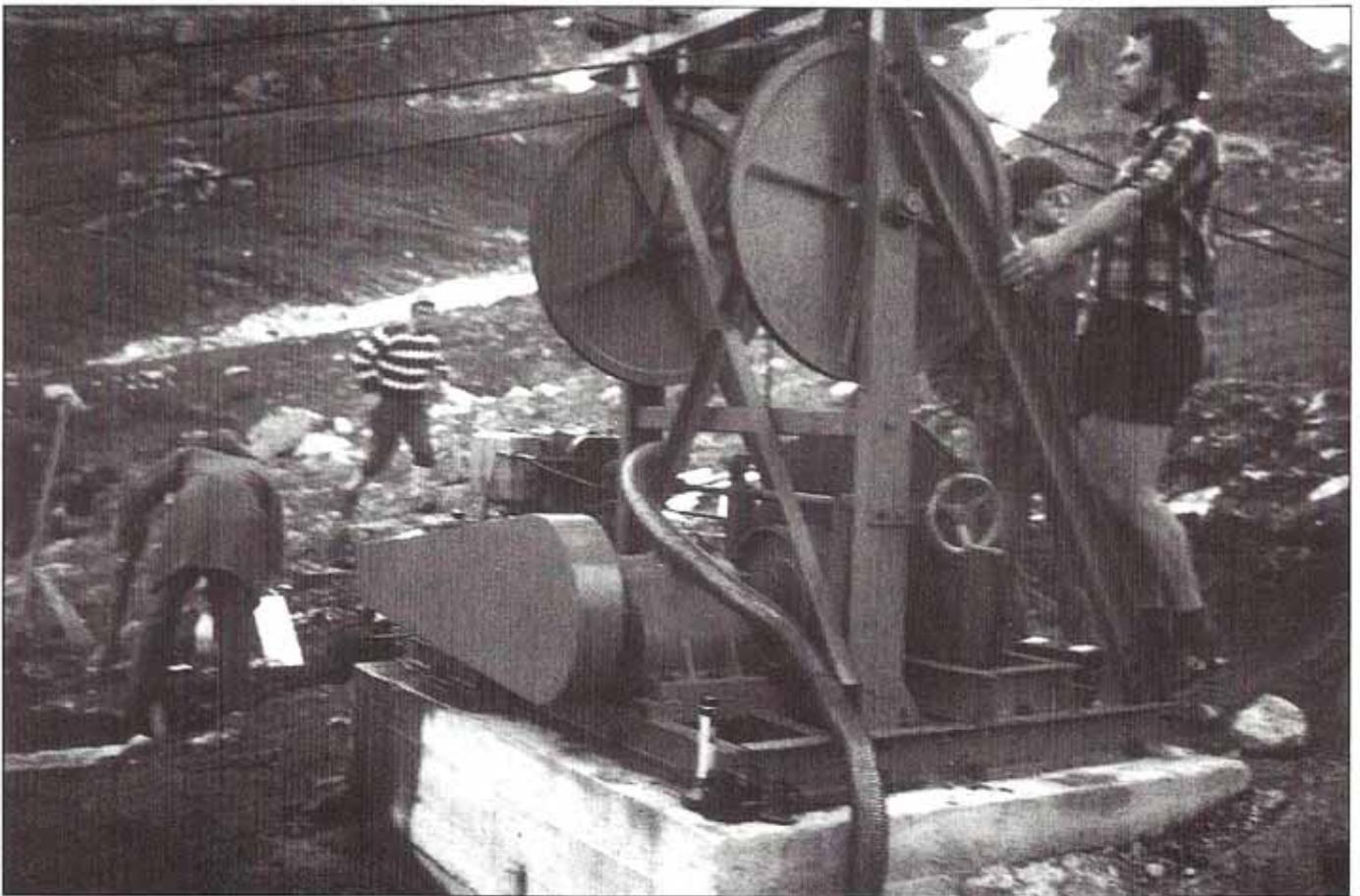
Der Dieselmotor der Materialeilbahn kurz nach Installation im September 1977. Nach langwierigen Genehmigungsverfahren konnten mit einer Ausnahmegenehmigung des Bayerischen Staatsministeriums zum vorzeitigen Beginn der Baumaßnahmen im August 1977 die ersten Stützmasten gesetzt werden. Bereits zum Hüttenschluß am 25. September wurde die Seilbahn vom Hüttenwirtehepaar Kreidl in Betrieb genommen.
