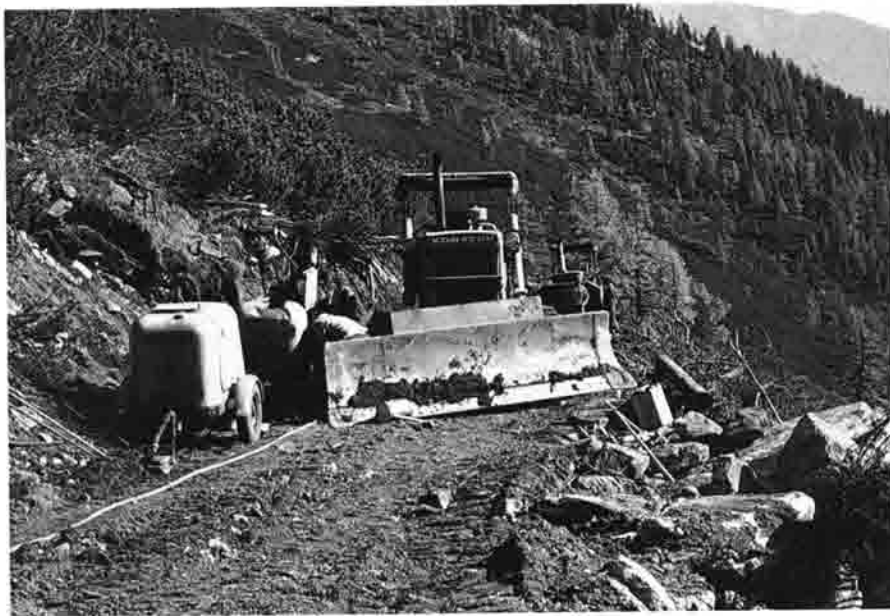
Wegebau zur neuen Hütte 1976
