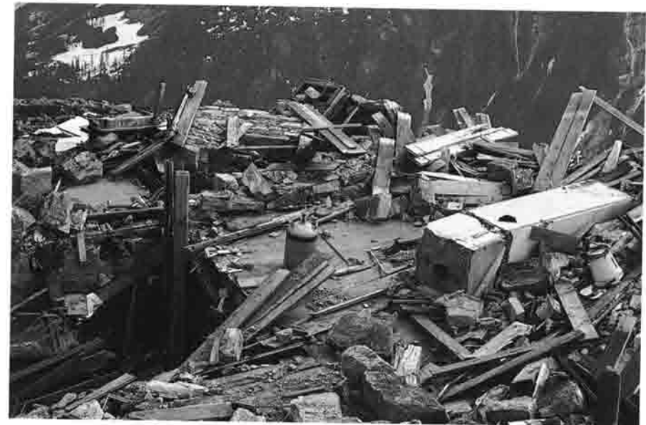
Die Trümmer der Gießener Hütte 1975
